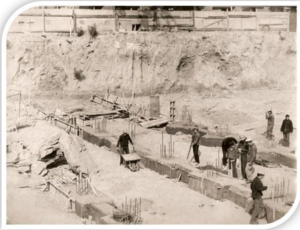
"Cofragul" pentru turnarea casetei și a grinzilor de subsol.
