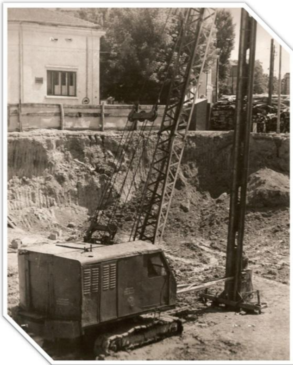
Poziționarea la cote pentru baterea unui pilon de 12 metrii.
