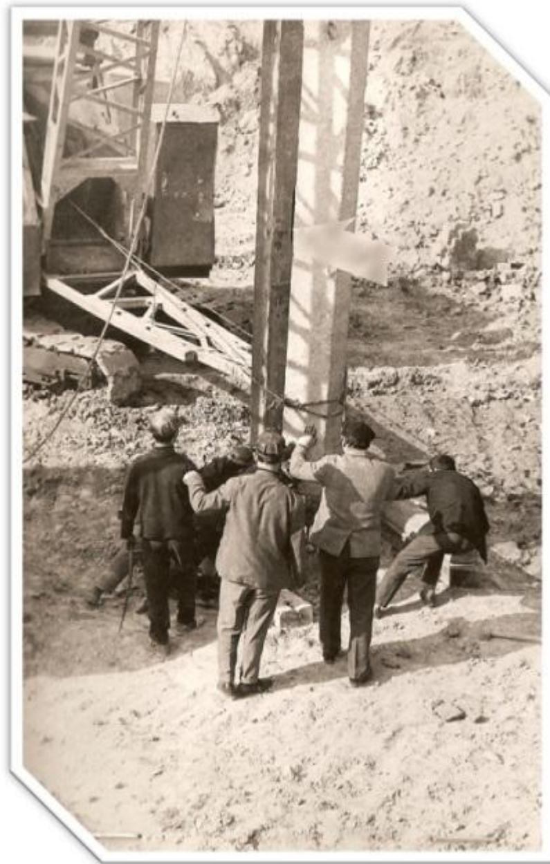
Zonele pilonilor bătuți s-a întins în punctele stabilite pe toată suprafața construcției.
